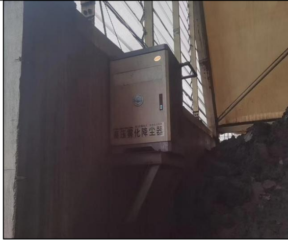
3#全封闭钢结构储煤库高压雾化除尘器
