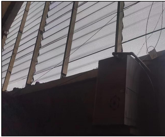
1#全封闭钢结构储煤库高压雾化除尘器
