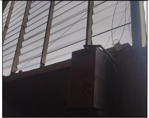
3#全封闭钢结构储煤库高压雾化除尘器
