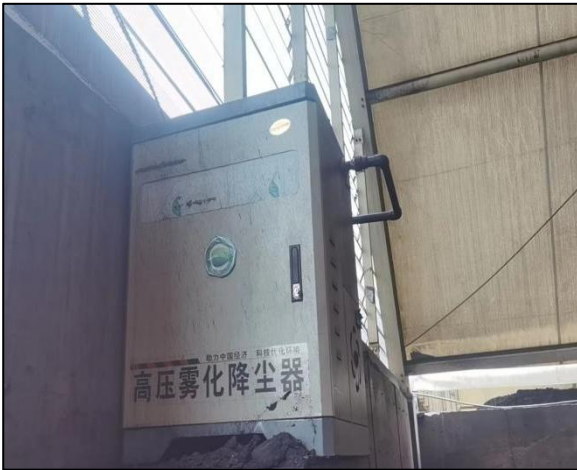
5#全封闭钢结构储煤库高压雾化除尘器
