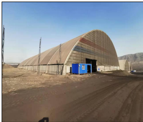
3#全封闭钢结构储煤库
