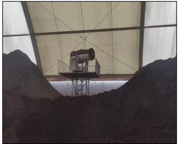
4#储煤库雾炮机
