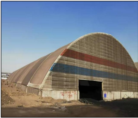
4#全封闭钢结构储煤库
