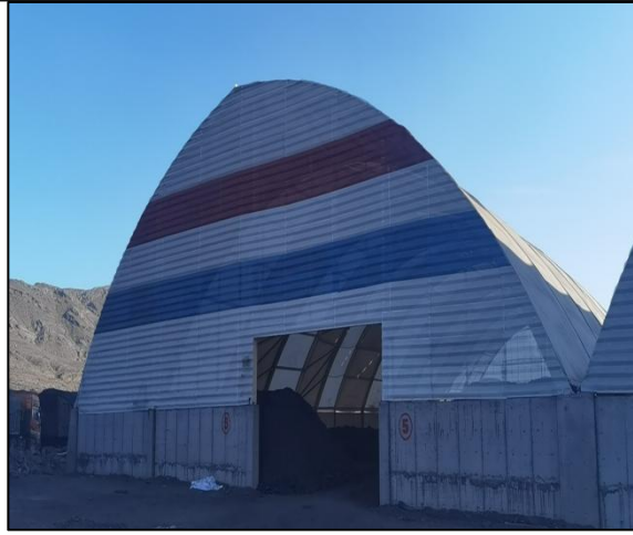
5#全封闭钢结构储煤库
