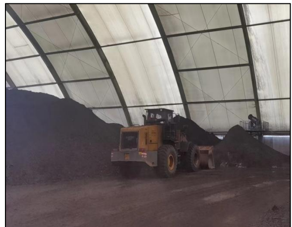
2#储煤库雾炮机
