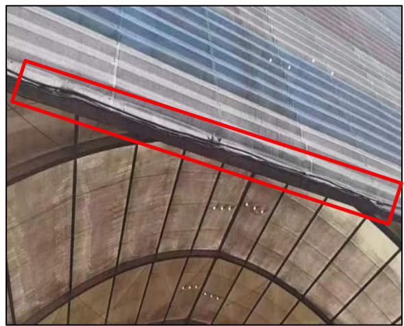
2#全封闭钢结构储煤库高压雾化除尘器
