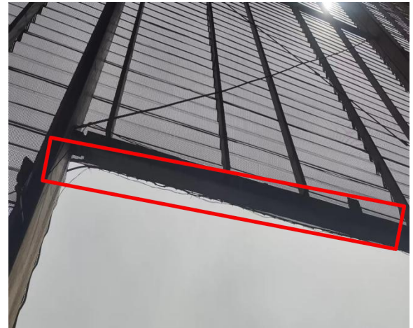
1#全封闭钢结构储煤库高压雾化除尘器
