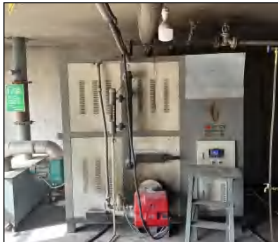
锅炉房沼气锅炉+15m 高排气筒
