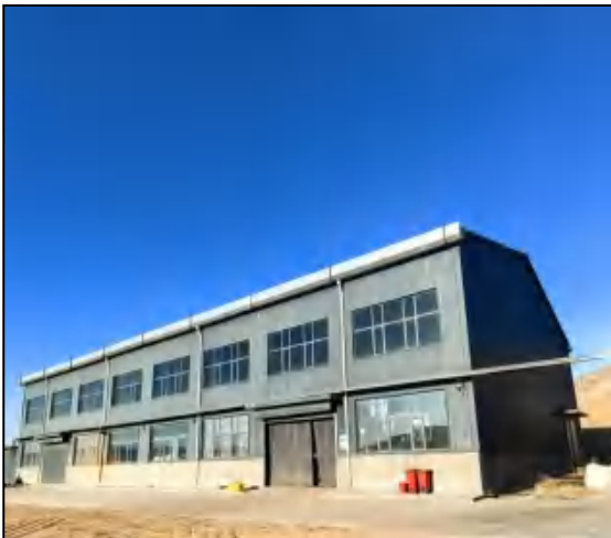
全封闭生产车间
