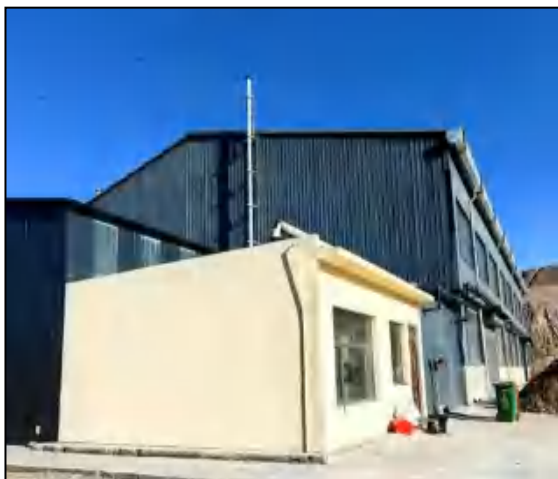
锅炉房沼气锅炉+15m 高排气筒
